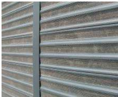
4 pav. Triukšmą absorbuojančių triukšmo užtvarų detalių pavyzdžiai 5 pav. Užtvoros aukščio modeliavimas
