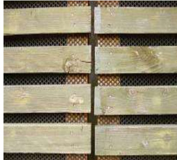
4 pav. Triukšmą absorbuojančių triukšmo užtvarų detalių pavyzdžiai 5 pav. Užtvoros aukščio modeliavimas
